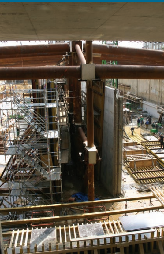
Gestempelde bouwput van fase 2 (situatie mei 2004)
